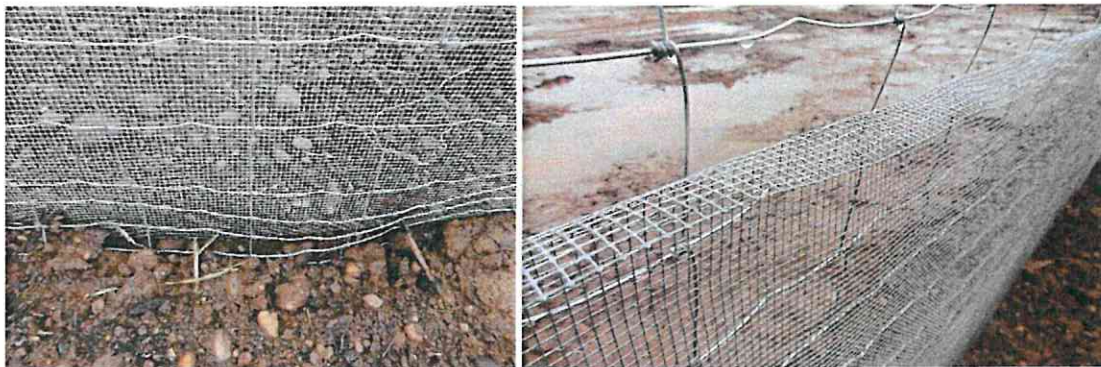
Double maillage enterré avec treillis incurvé sur la partie haute pour éviter le franchissement de la barrière notamment par les amphibiens – CBE, 2018
