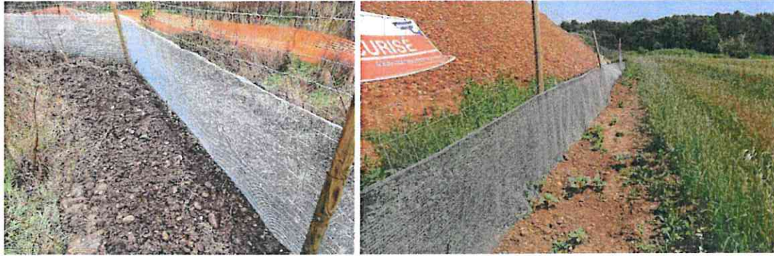
Exemple de clôture mis en place en limite d'un chantier pour contraindre le passage de la petite faune - CBE, 2018
