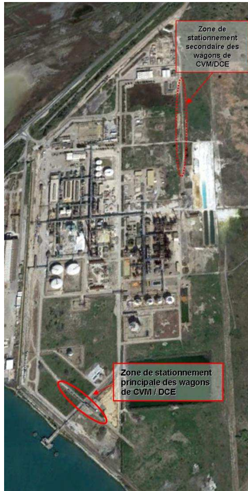
Zones de stationnement des wagons de CVM / DCE sur l'emprise du site de Kem One
