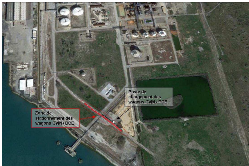
Zone de stationnement principale des wagons de CVM / DCE
