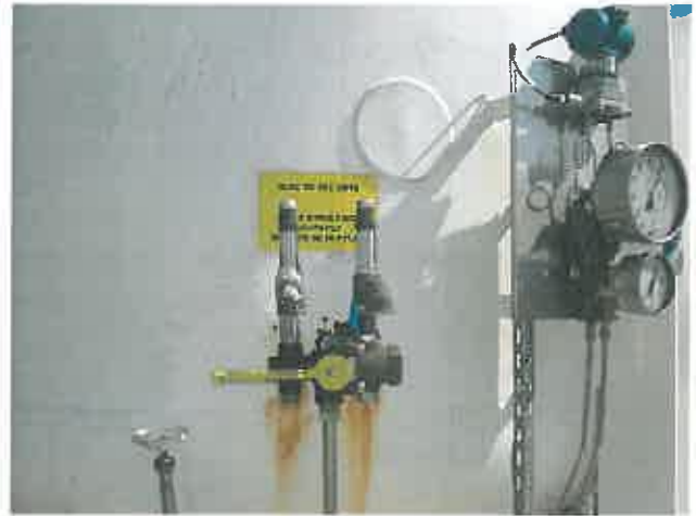
Vanne par laquelle l'azote a été mis à l'air libre
