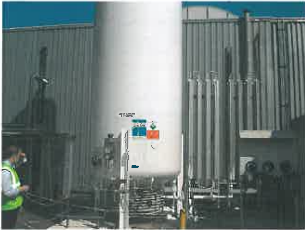
Cuve d'azote
