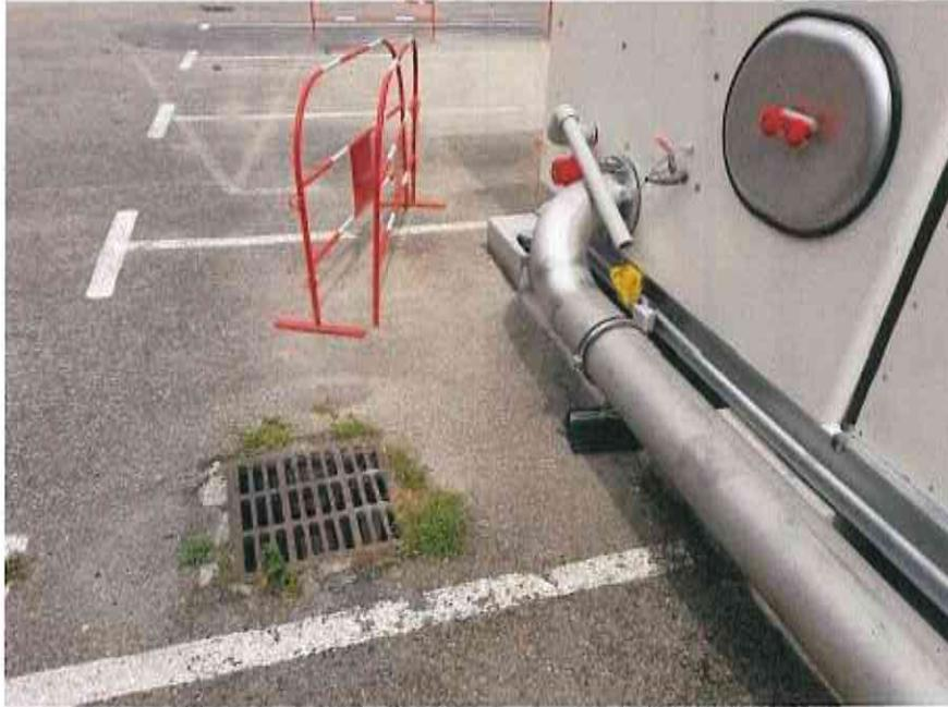
*Figure 1: Surverse et regard d'eau pluviale*
