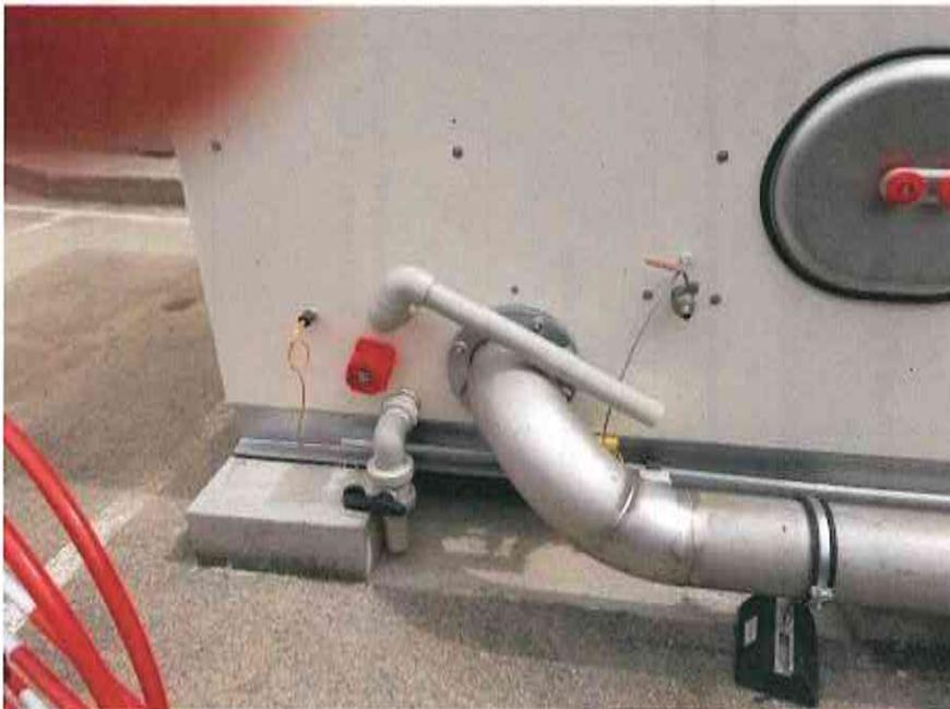
*Figure 2: Emplacement des sondes de niveau d'eau*
