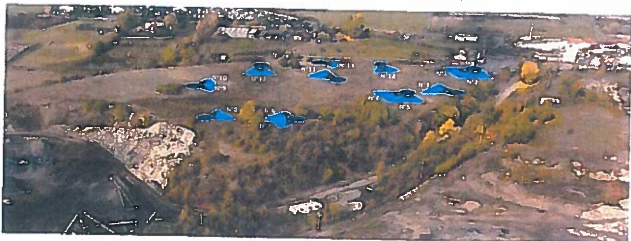
Vue aérienne de la zone remise en état
