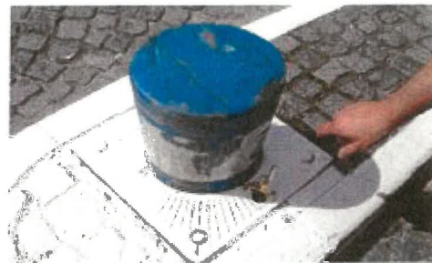
Borne escamotable et triangle de 15 mm
