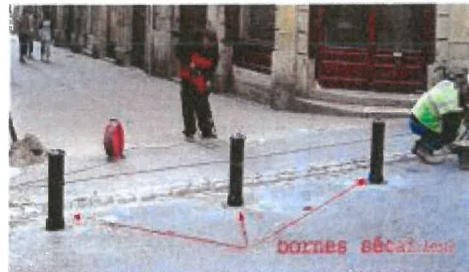
Bornes sécables par un homme sur poussée
