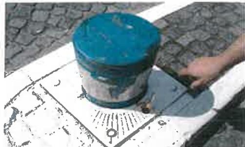
Borne escamotable et triangle de 15 mm
