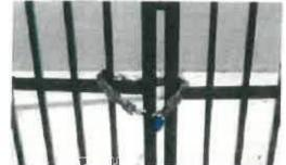
Chaîne ou cadenas de 12 mm maximum, sécable au coupe boulon
