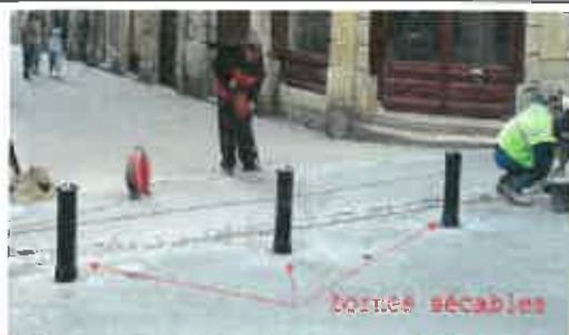
Bornes sécables par un homme sur poussée
