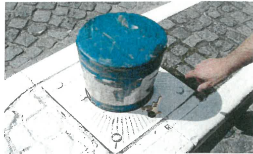
Borne escamotable et triangle de 15 mm
