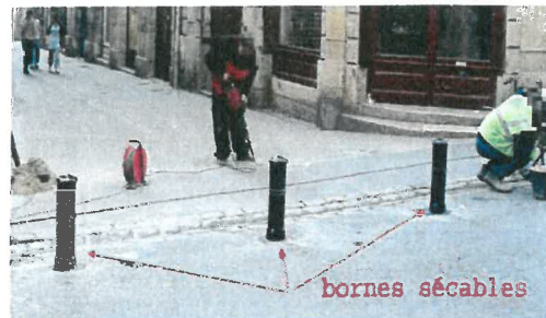
Bornes sécables par un homme sur poussée
