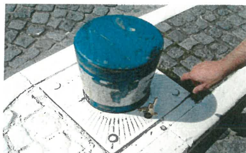
Borne escamotable et triangle de 15 mm
