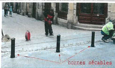
Bornes sécables par un homme sur poussée
