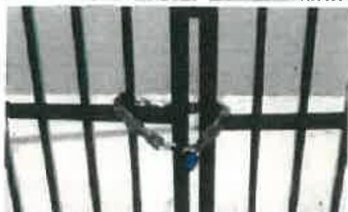
Chaîne ou cadenas de 12 mm maximum, sécable
