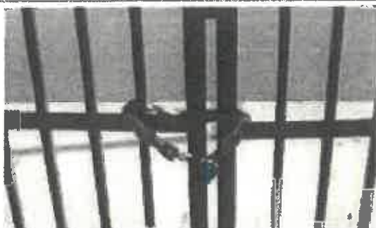
Chaîne ou cadenas de 12 mm maximum, sécable au coupe boulon
