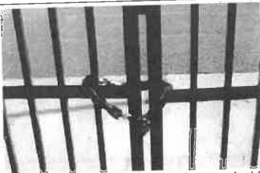
Chaîne ou cadenas de 12 mm maximum, sécable
